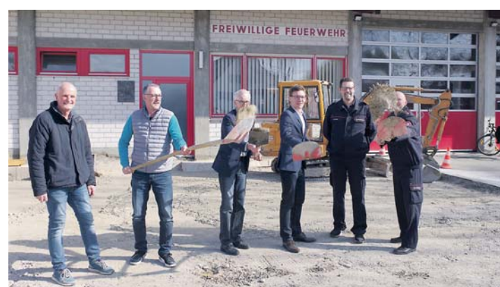
Beim Spatenstich: Bauunternehmer Matthias Baur aus Hausen, Architekt Joachim Binder, Bürgermeister Alfred Mutter, sein gewählter Nachfolger Marcus Röwer, der stellvertretende Kommandant Dirk Schmid und Kommandant Jürgen Sapper.
