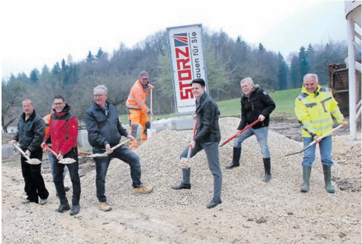
Mit dem Spatenstich wurde der Startschuss für die Erschließung des neuen Baugebiets in Tengen-Weil gegeben. Dritter von rechts Bürgermeister Marian Schreier.
