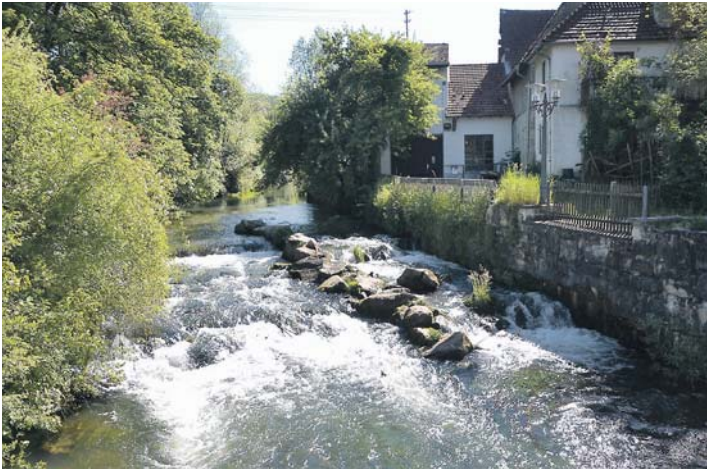
Die Aach erlebbar machen ist ein Teil der Ortssanierung.
