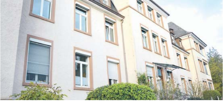
Das Friedrichsheim wurde einer neuen Nutzung für Kinder und Jugendliche zugeführt.
