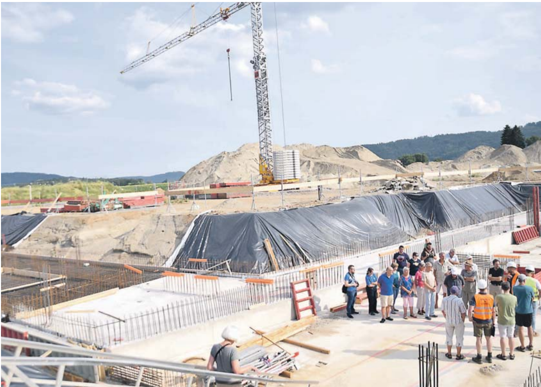
Imposante Eindrücke sammelten die Bürger beim ersten Baustellengespräch der neuen Eichendorff-Realschule.
