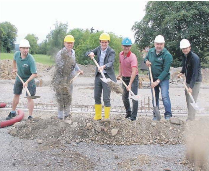
Mit dem Spatenstich für den Wirtschafts anbau auf dem Festplatz steht den Mitgliedern der Stadtkapelle Tengen große Erleichterung bei der Bewirtschaftung auf dem Schätzelemarkt an. In dem 35 auf 6,5 Meter großen Anbau sollen Küche, Theke, Technik und Kasse untergebracht werden. Zudem entfallen die mühsamen Auf- und Abbauten. Die Fertigstellung des Anbaus ist für den diesjährigen Schätzelemarkt geplant. Im Bild von links: Claudius Weber (Vorstand Stadtkapelle Tengen), Wolfgang Kroschk (Maurermeister), Bürgermeister Marian Schreier, Planer Christian Weber, Edwin Keller (Vorstand des Fördervereins/Bauleiter) und Manuel Leute (Vorstand Stadtkapelle). swb-Bild: Stadt Tengen
