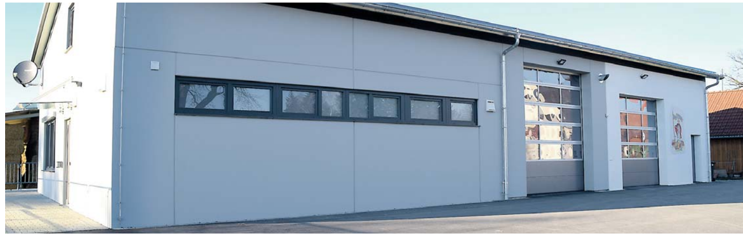
Stolz ist die Feuerwehr Mahlspüren im Hegau auf die nun fertiggestellte Erweiterung ihres Gerätehauses, das am Sonntag eingeweiht werden kann. swb-Bild: FFW Mahlspüren/Wenger
