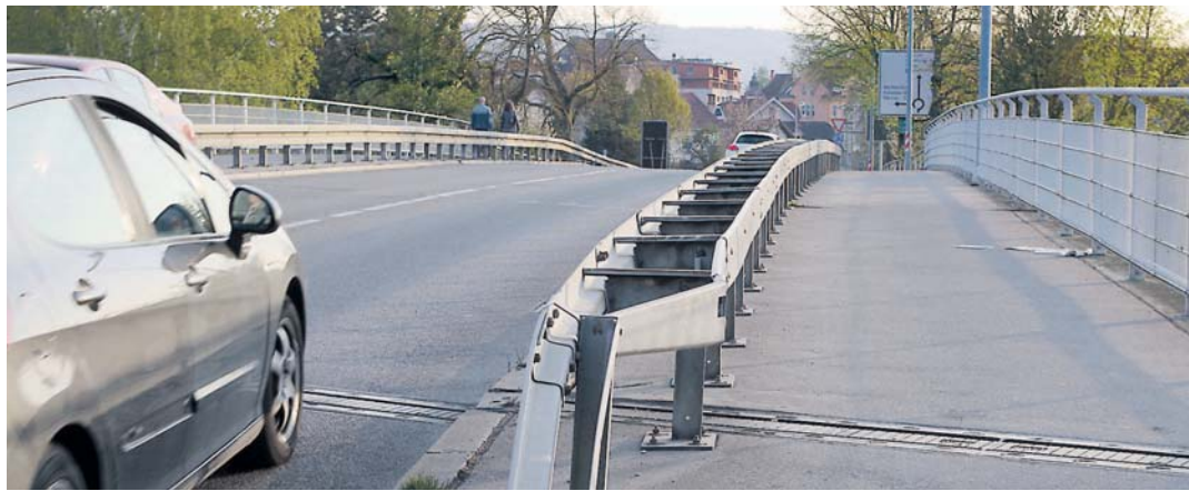
Schon immer waren Fahrbahn und der Rad/Fußweg an der Konstanzer Brücke getrennt. Das soll auch nach einer Sanierung so bleiben, fordert der Radolfzeller Gemeinderat mehrheitlich. Das Bild verdeutlicht auch, wie nah die Autos den Radlern auf die Pelle rücken.
