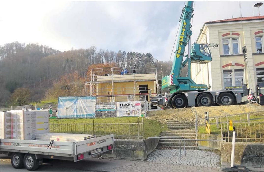
Die Arbeiten am neuen Anbau waren hier im August 2018 in vollem Gange.
