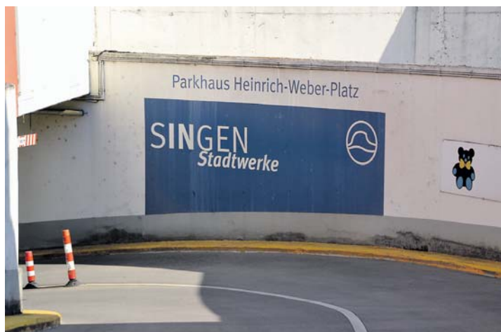
Die Sanierung der Tiefgarage am Heinrich-Weber-Platz soll erst in diesem Jahr vorgenommen werden und schlägt mit 520.000 Euro beim Wirtschaftsplan der Stadtwerke zu Buche.
