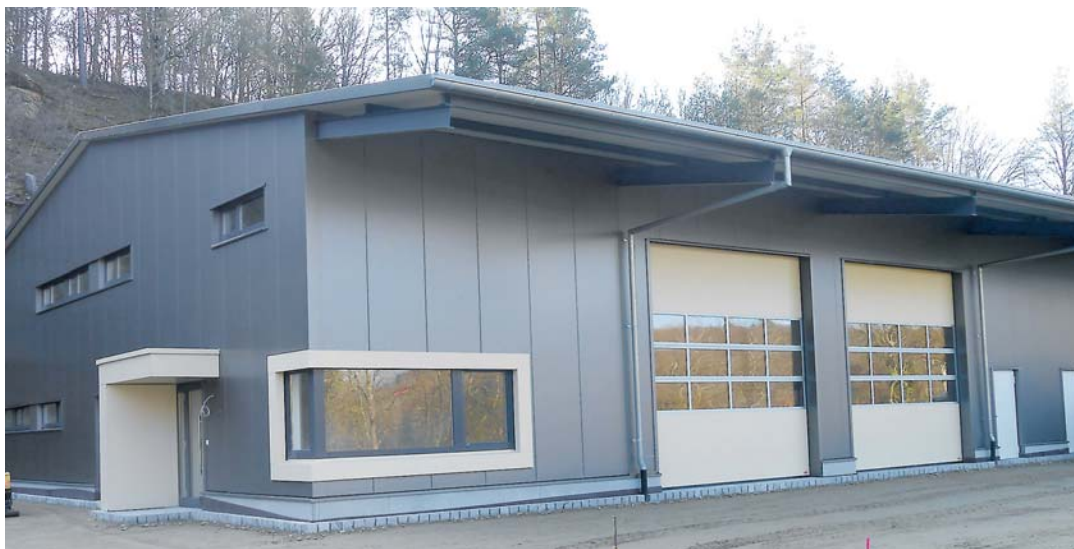
Funktional gut aufgeteilt bringt der neue Bauhof der Stadt Tengen viele Vorteile in den Abläufen.
