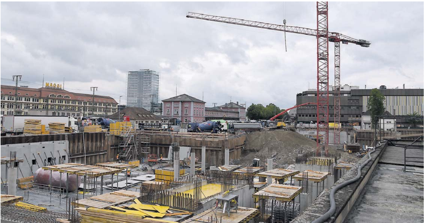
Die Bauarbeiten für das Cano schreiten zügig voran.
