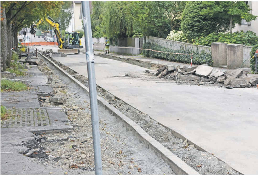
Umfangreiche Pflaster und Asphaltarbeiten sind im Zuge der Fahrradstraße in der August-Ruf-Straße noch bis zum 16. September im Gange. swb-Bild: stm
