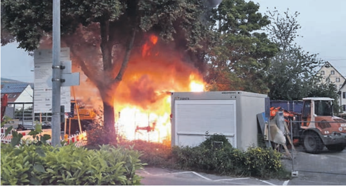
In Flammen standen Gitterboxen mit Kunststoffrohren auf einer Baustelle in der Bahnhofstraße. swb-Bild: FFW Engen
