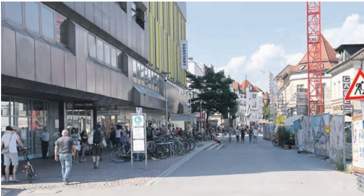
Die Neugestaltung der Fußgängerzone zwischen des im Bau befindlichen Einkaufszentrums und Karstadt soll im September beginnen.
