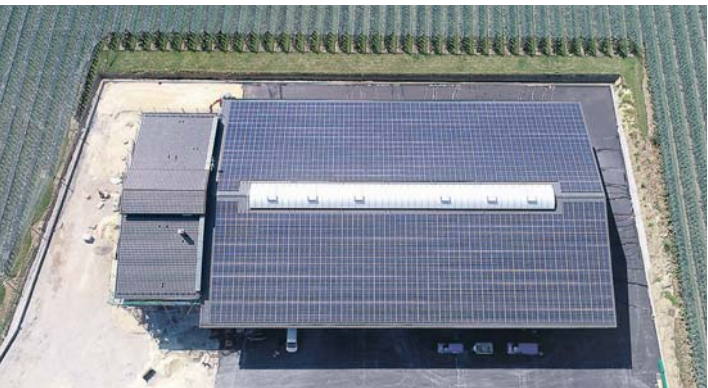
Die neue Obsthalle von Bodman aus der Luft betrachtet. Fast die gesamte Dachfläche liefert Sonnenstrom. swb-Bild: solarcomplex
