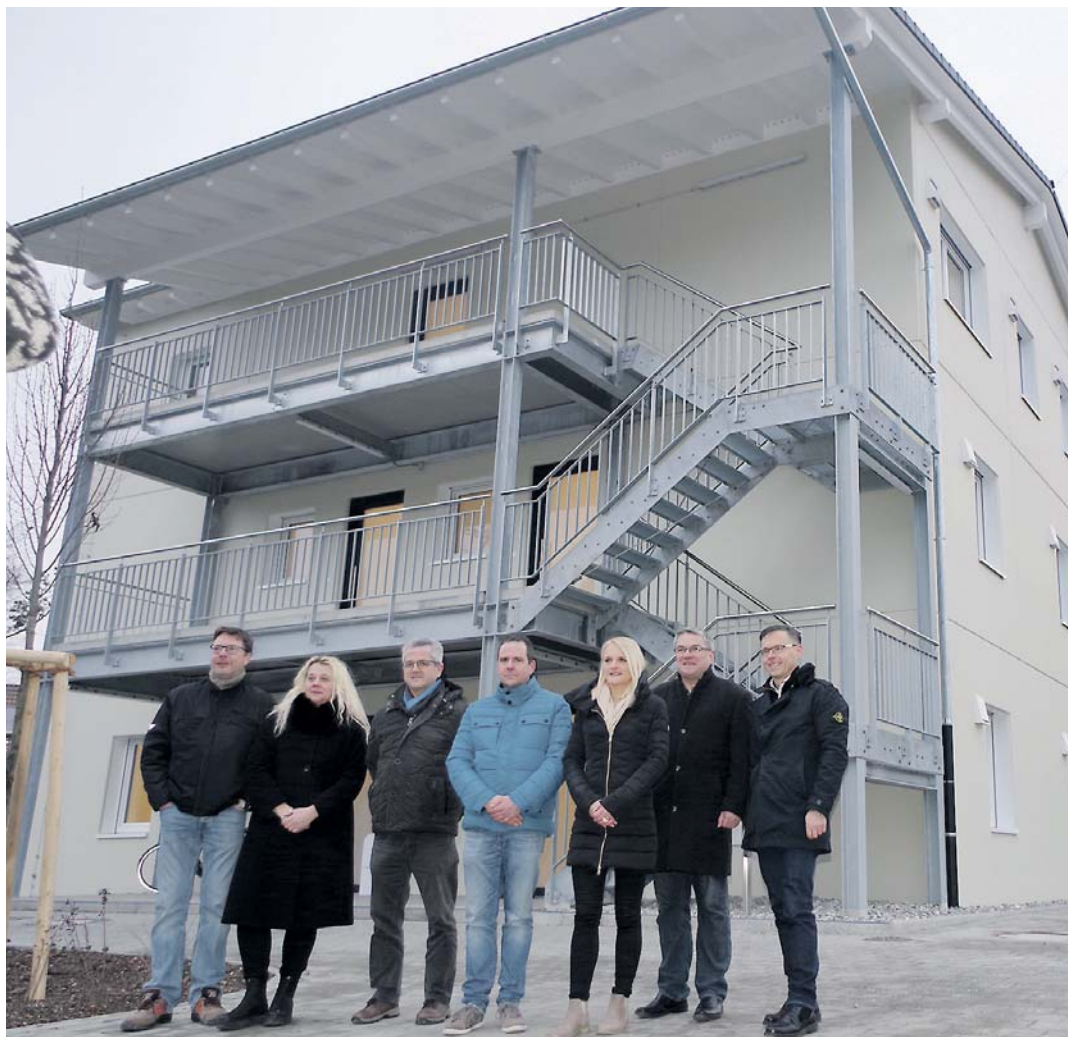
Im Bild bei der Einweihung des Neubaus an der Zeppelinstraße: Ralf Ebenslander und Karin Schmidt vom Bauamt der Gemeinde, Winfried Rauscher und Thomas Silberberger und Nadine Stotz von FBW, Bürgermeister Ralf Baumert und Jürgen Baumann, technischer Leiter von FBW. swb-Bild: of
