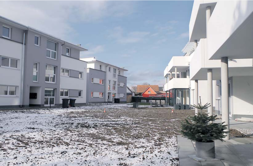
Ein schönes kleines Quartier mit Innenhof wurde an der Worblinger Hardstraße fertig gestellt.
