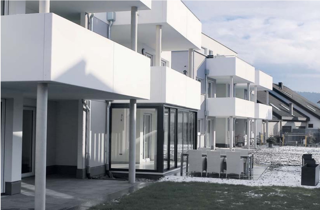
Die Käufer der Wohnungen konnten im Zuge der Bauphase vieles individuell gestalten.
