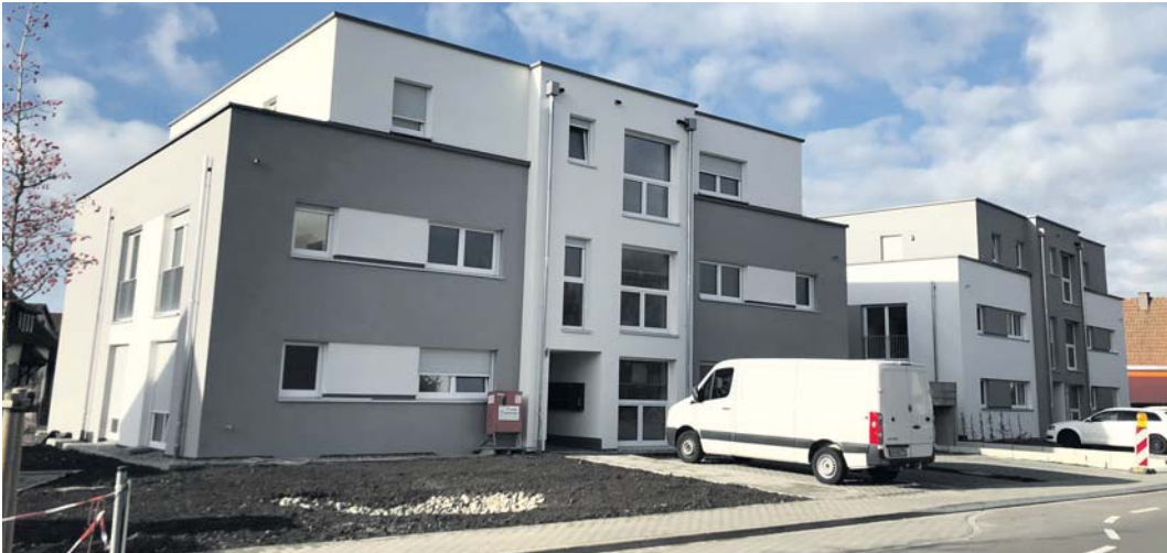
Von der Hardstraße aus gesehen setzen die Neubauten stilvolle Akzente der aktuellen Architektur im gewachsenen Ensemble.
