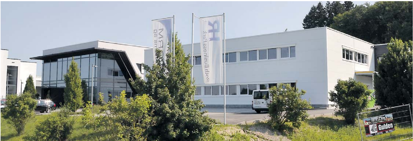
Der Neubau ist bis auf ein paar Kleinigkeiten fertig.
