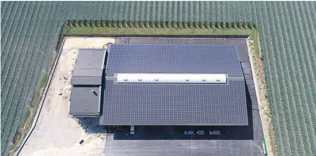
Immer mehr Unternehmen werden durch Sonnenstrom zum Selbstversorger, wie hier an der neuen Obst-swb-Bild: solarcomplex
