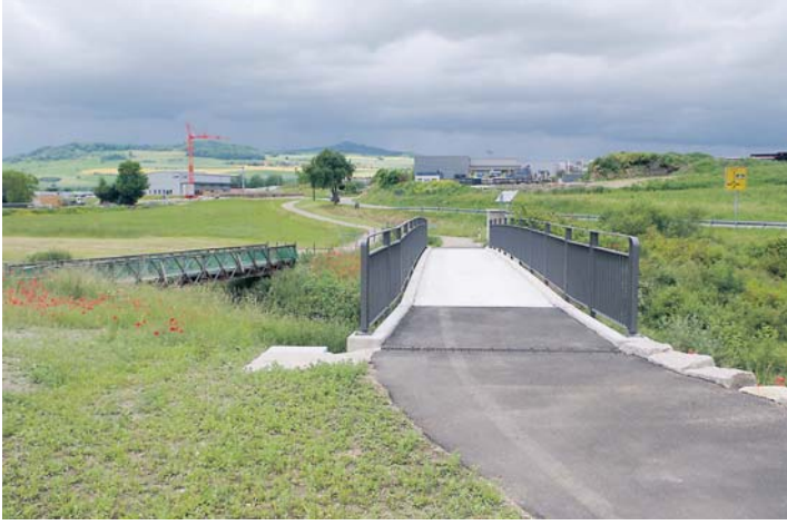
Sieht seit Wochen schon fertig ist, ist aber noch nicht ganz vollendet. Die neue Radwegbrücke über den Riederbach zwischen Hilzingen und Gottmadingen.
