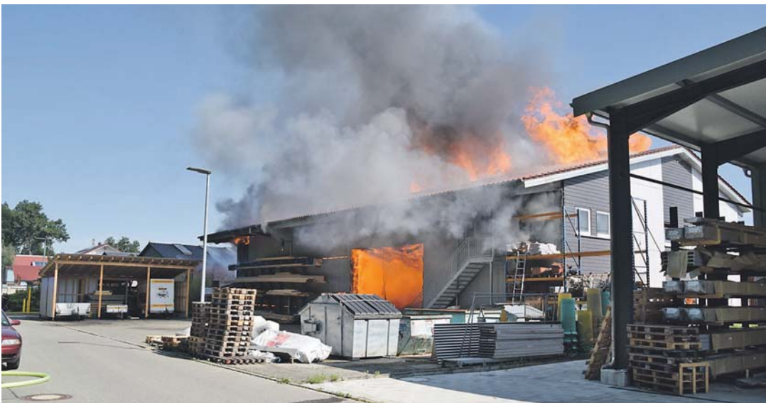
Die 20x30 Meter große Halle der Firma Rixen Dach im Mooser Gewerbegebiet stand am Freitag in Vollbrand.
