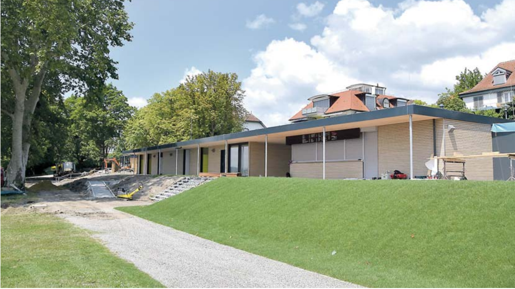
Die letzten Arbeiten werden noch ausgeführt, bevor das neue Seebad ab dem 19. Juli, 15 Uhr wieder für die Badegäste zur Verfügung steht.
