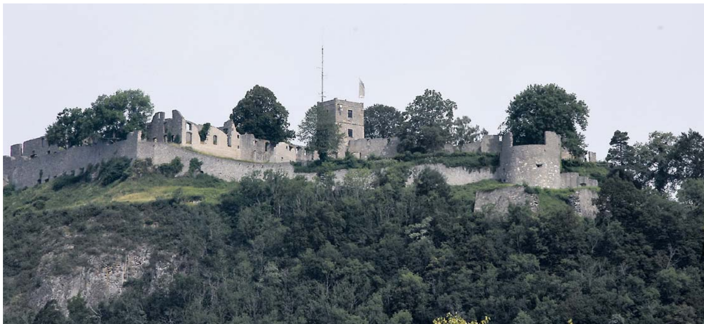
Ziemlich ruhig wird es dieses Jahr auf dem Hohentwiel noch nach dem Felssturz aus Sicherheitsgründen bleiben. Verschiedene Felspartien müssen mit Fanggittern gesichert werden. Bevor diese Maßnahmen ausgeschrieben werden können müssen sie mit dem Denkmal- wie Naturschutz abgestimmt werden.
