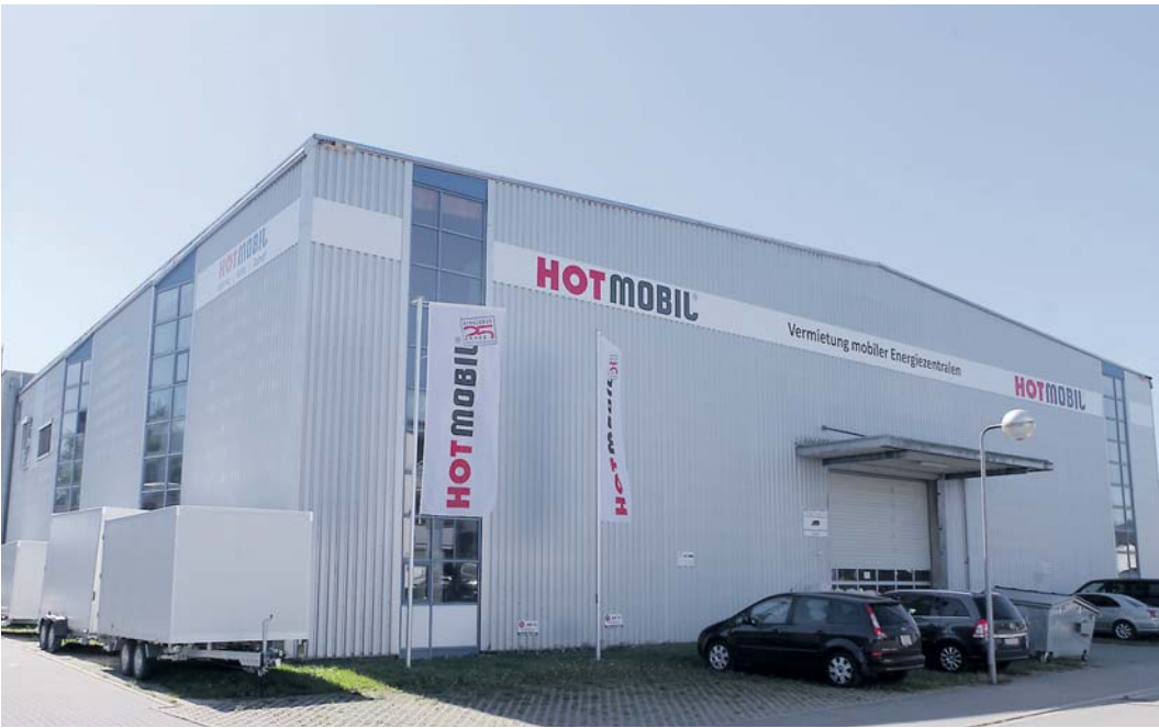
Seit kurzen ist das ganze Unternehmen Hotmobil an seiner Zentrale in Gottmadingen im Gewerbegebiet Goldbühl an einen Standort in der Zeppelinstraße vereint. Ein weiterer wichtiger Schritt in der spannenden Firmengeschichte. swb-Bild: of
