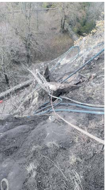
Herunterfallende Steine wurden durch das Fangnetz aufgefangen.
