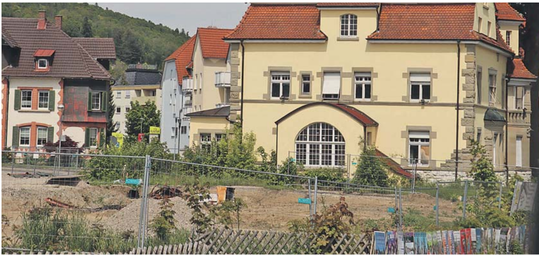
Die Abrissarbeiten der Nebengebäude auf dem Areal der »Villa Graf« in Gottmadingen gingen zügig vonstatten, doch dann geriet das Projekt ins Stocken. Nun soll die Villa aus ihrem Dornröschenschlaf geweckt werden.
