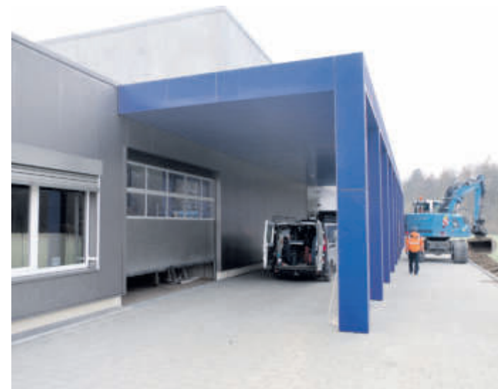
Der künftige Logistikbereich mit den Rampen für An- und Auslieferung ist bereits fertiggestellt.
