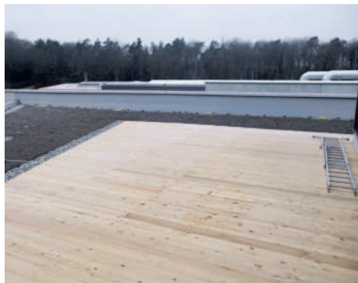
Der Dachbereich um die Verwaltungsräume ist nochmals eine Oase für sich geworden.
