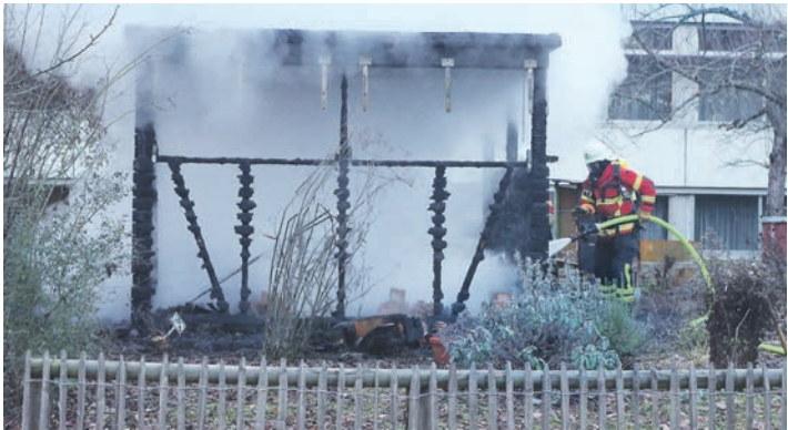
Die Feuerwehr Singen beim Einsatz in der Brandruine des Bienenstands am Friedrich-Wöhler-Gymnasium. swb-Bild: of
