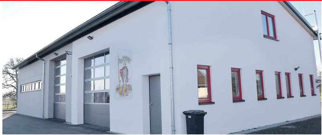
Insgesamt 168 Quadratmeter Grundfläche bietet das Gerätehaus in Mahlspüren nach der Erweiterung. Das bedeutet Platz für zwei Fahrzeuge, Schlulungs und Sanitarräume für Damen wie Herren.
