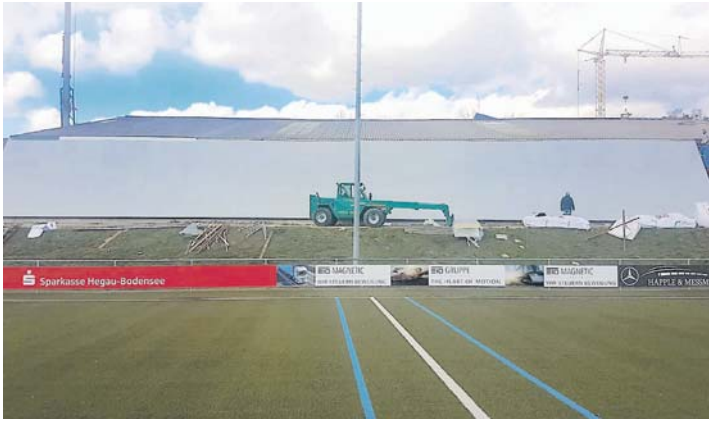
Das Dach der Tennishalle des Tennisparcs Stockach wird zur Zeit erneuert.
