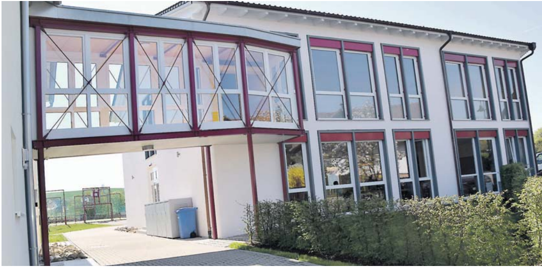
Orsingen-Nenzingen wird sich in den nächsten Jahren dank der Baugebiete stark entwickeln. Im vergangenen Jahr etwa wurde der Anbau der Grundschule fertiggestellt.
