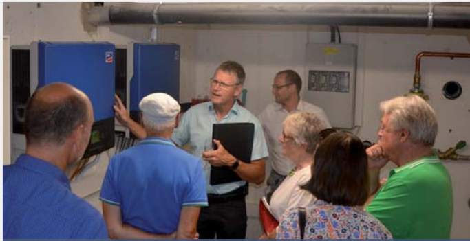
Die Bewohner der Kasernenstraße 63 beziehen ihren Ökostrom direkt vom Dach dank einer Photovoltaikanlage und nutzen ihn auch direkt ohne Umweg über das öffentliche Stromnetz (hier im Keller an den Wechselrichtern der PV-Anlage)
