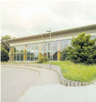
Zu den zu sanierenden Objekten gehört das Hallenbad Stockach, das mit rund 574.000 Euro gefördert wird. swb-Bild: Stadtwerke Stockach
