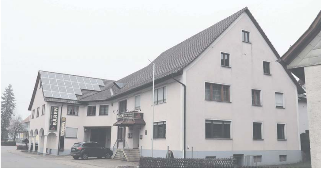
Der ehemalige Landgasthof »Bären« in Hohenfels-Liggersdorf soll künftig altersgerechte Wohnungen, Raum für Existenzgründer und »Co-Working-Plätze« beherbergen. swb-Bild: ml
