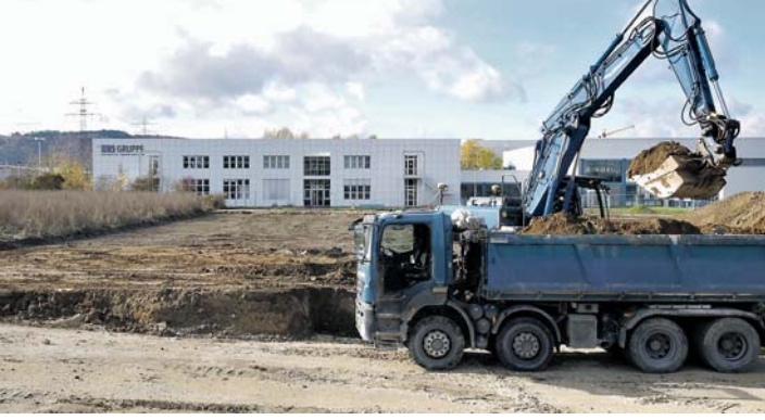
Die ETO GRUPPE in Stockach baut derzeit ein neues Technikzentrum. Derzeit finden Aushubarbeiten statt. swb-Bild: ETO GRUPPE
