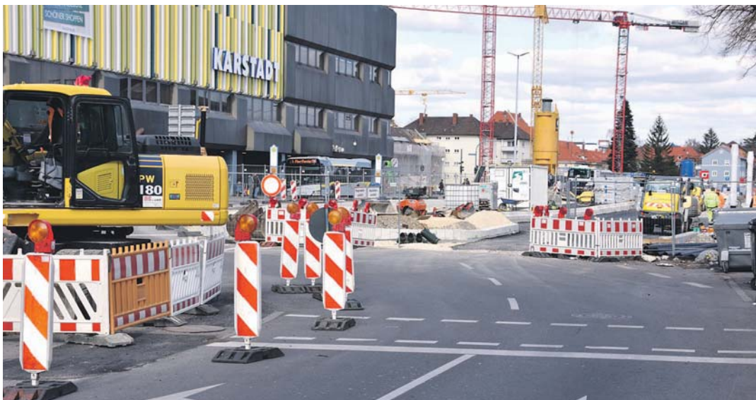
Die Baustelle am Bahnhofplatz führt zu massiven Verkehrsbeeinträchtigungen. Denn selten ist die Bahnhofstraße so leer wie auf dem Foto (siehe unten). swb-Bild: stm
