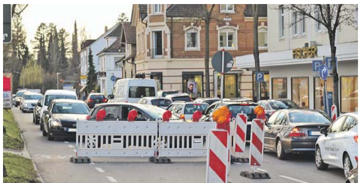
Stau in der Bahnhofstraße nach Einrichtung der Baustelle an der Erzbergerstraße. swb-Bild: Paul Georg Wengert
