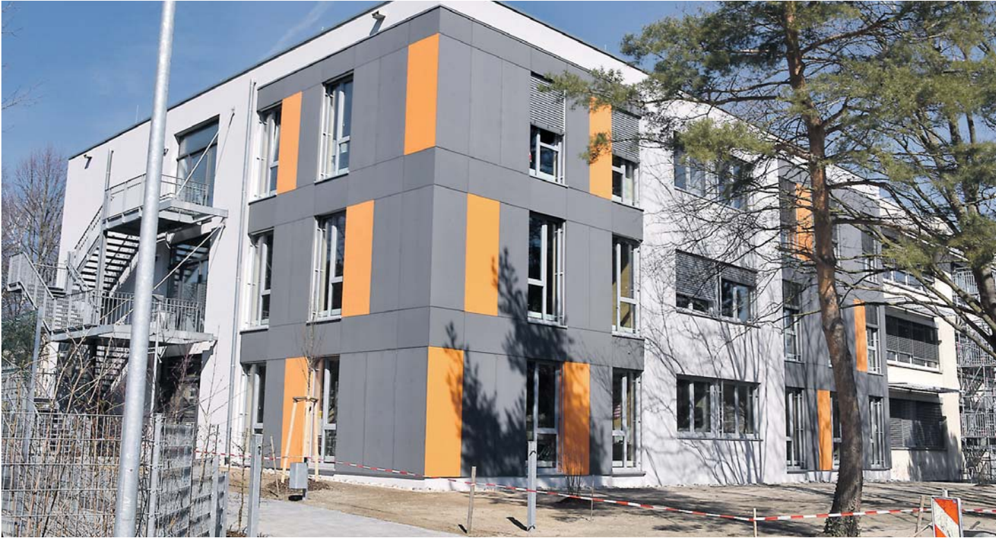
Im Erweiterungsneubau der Beethovenschule sind die Klassen 8 - 10 untergebracht. Die Feuertreppe konnte vom Altbau übernommen werden. swb-Bilder: stm
