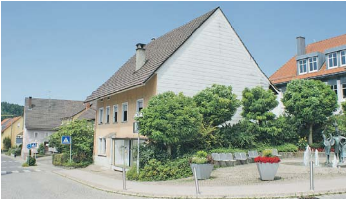
Hier soll das neue Steißlinger Ärztehaus ab dem neuen Jahr entstehen.
