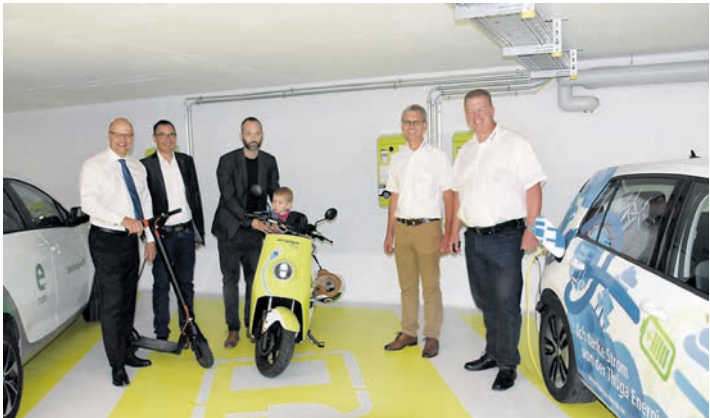
Drei Elektro-Ladesäulen in der Tiefgarage hat die Thüga eingerichtet. Thüga-Chef Markus Spitz (links) mit seinen Mitarbeitern - auf dem Foto mit Künstler Luskas Schneeweiss und Sohn (Mitte).
