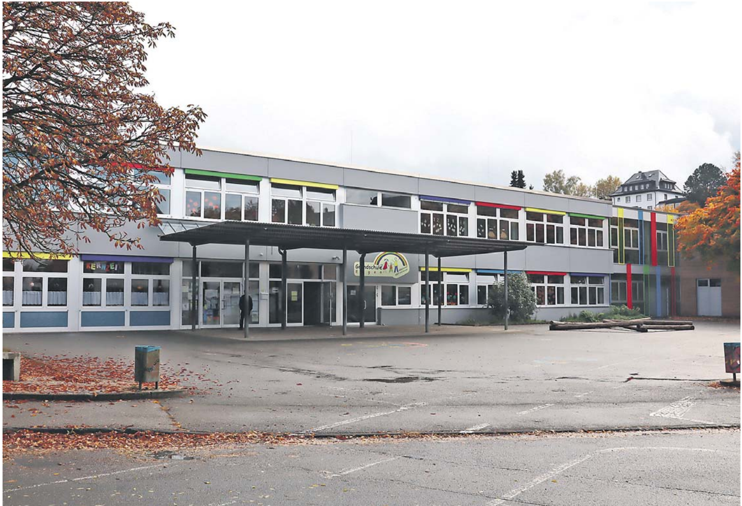
Der Neubau der Grundschule steht, nun wird noch das Außengelände in Angriff genommen.
