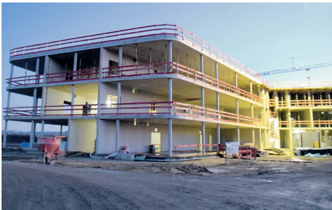
Kann sich sehen lassen: Der Rohbau der neuen Eichendorff-Realschule ist fast fertig. swb-Bild: ver
