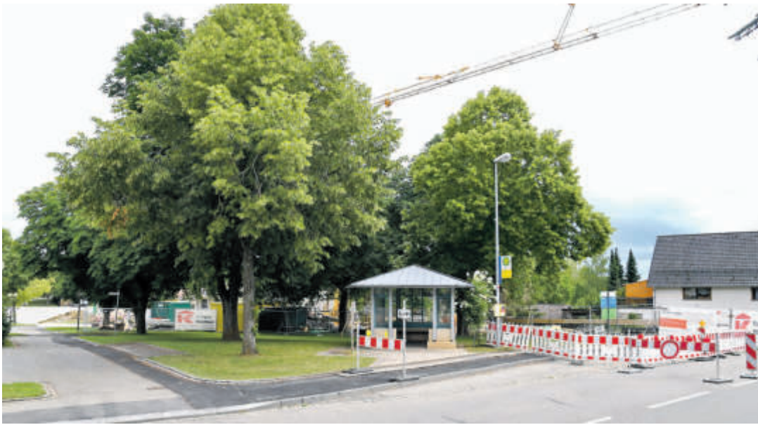
Die Baustelle für das Ärztehaus am Tengener Kastaniengarten kommt gut vorbei. swb-Bild: K. Preter
