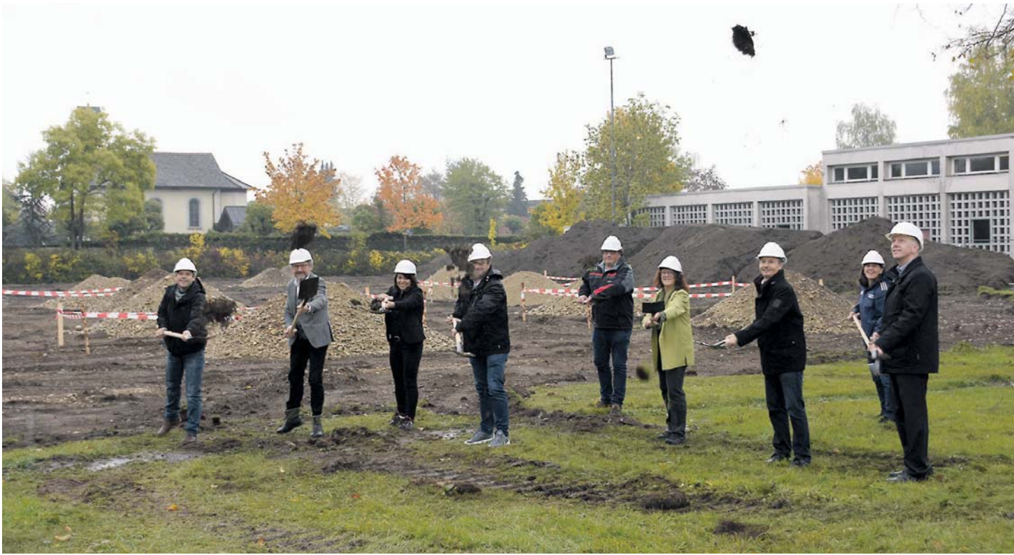
Die Gemeinderäte rund um Bürgermeister Johannes Moser (r.) beim Spatenstich der neuen Sporthalle, die für den Schulsport genutzt werden soll und allen Sportvereinen zur Verfügung steht. swb-Bild: ver
