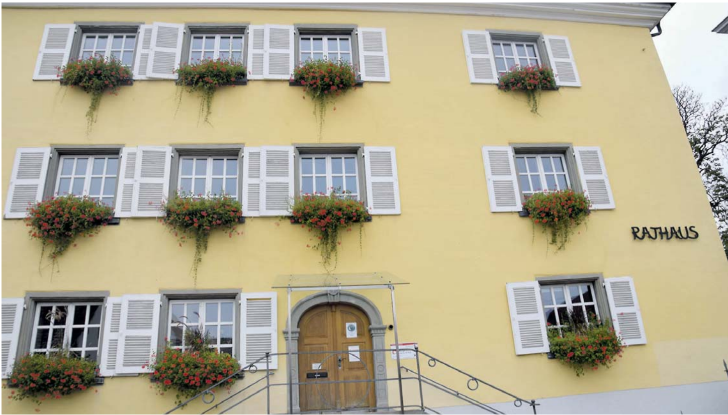
Das Hilzinger Rathaus soll ab dem nächsten Jahr umfassend saniert werden.
