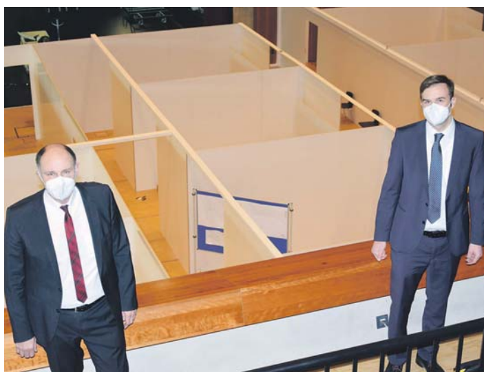
Noch vor Weihnachten inspizierten Landrat Zeno Danner und der Singener OB Bernd Häusler die ersten Aufbauarbeiten für das Kreisimpfzentrum in der Stadthalle. Sie werden erst am 4. Januar fortgesetzt.
