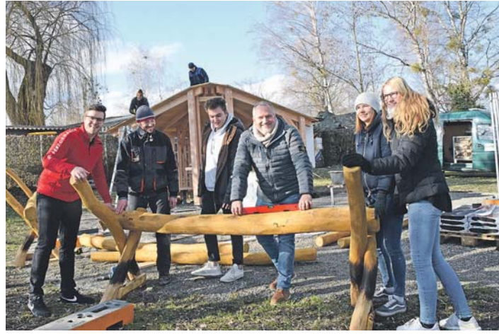
Beim Aufbau der ersten Jugendhütte im Herzenbad schaute auch OB Martin Staab vorbei und legte beim Aufbau einer sogenannten »Lümmelbank« mit Hand an. swb-Bilder: dh
