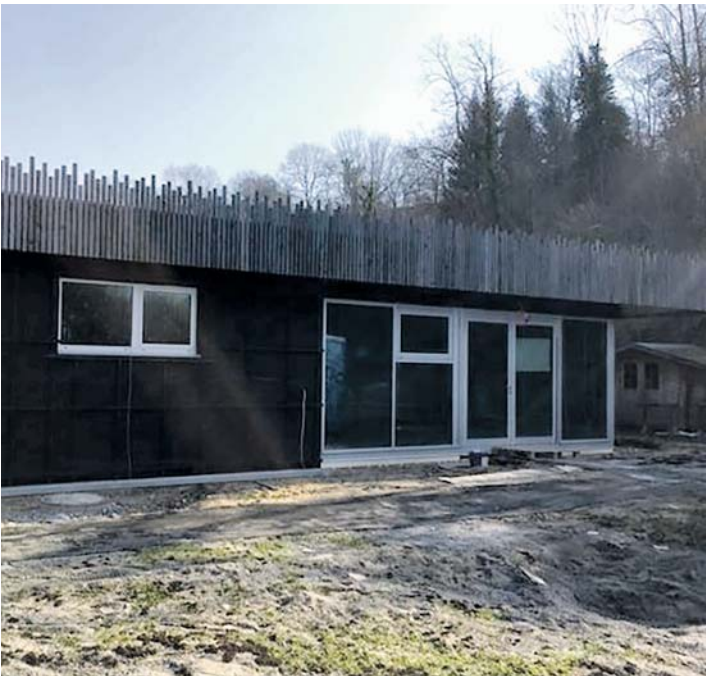
Der Inbetriebnahme der dritten Gruppe der Kinderkrippe im Baumgarten in Engen zum 1. April stand aus baulicher Sicht nichts im Wege. Allerdings ist durch die aktuelle Corona-Situation die pünktliche Inbetriebnahme durch das Kindergarten-Team nicht möglich. swb-Bild: Stadt Engen
