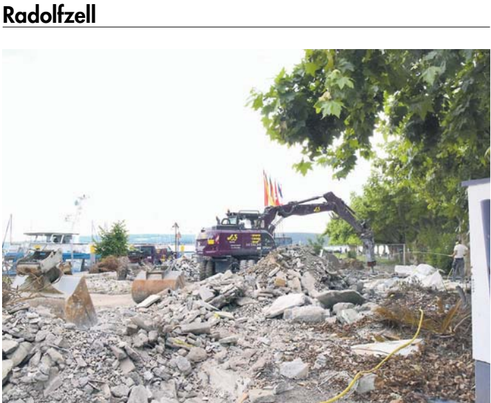
In der vergangenen Woche ist das alte Molencafé endgültig verschwunden. Nur noch einige Schutthaufen deuten auf das Gebäude hin. Die letzten Abrissarbeiten laufen indes noch. Insgesamt waren vier Wochen für den Abriss eingeplant. Der Baubeginn für das neue Gastronomiegebäude, das im Stil eines Bootshauses geplant ist, ist für Dezember 2020 angesetzt. Im Frühjahr 2022 soll das Gebäude an der Mole eröffnet werden, wenn alles glatt läuft. swb-Bild: dh
