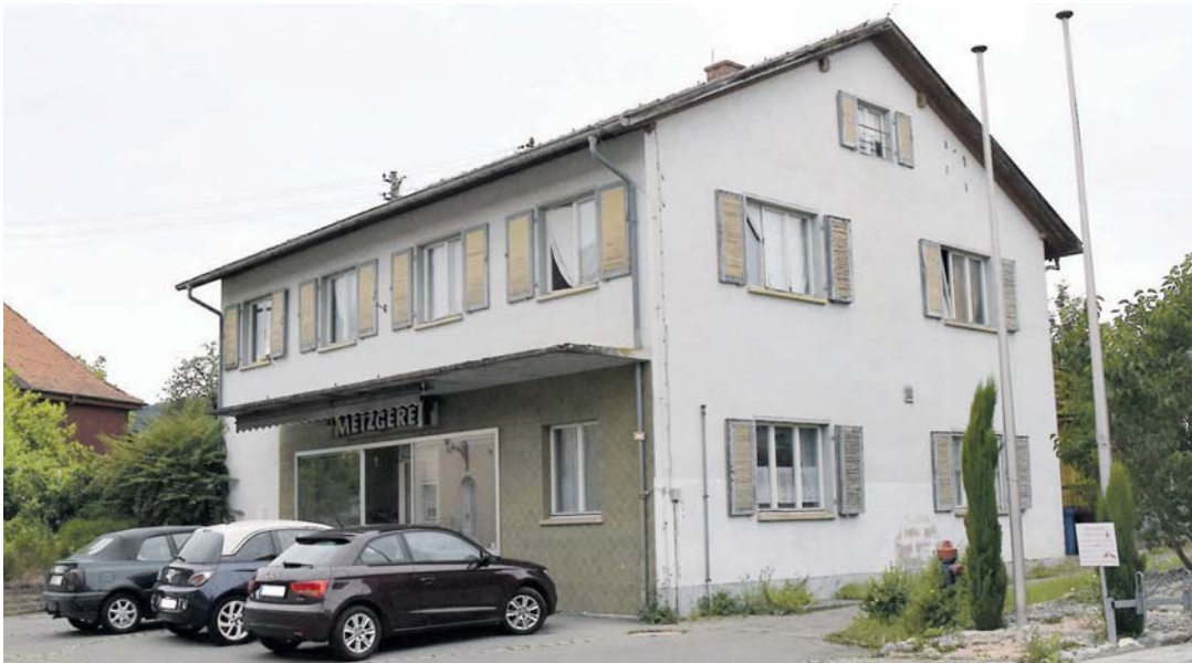
Die alte Metzgerei in Öhningen diente bisher noch als Anschlussunterbringung für Flüchtlinge. Aufgrund des schlechten baulichen Zustands soll der letzte Bewohner baldmöglichst anderweitig untergebracht werden.
