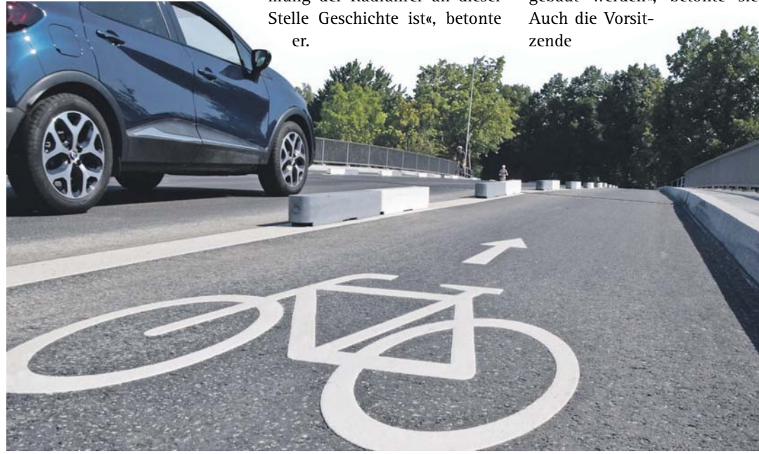
Die Radfahrstreifen sind 2,10 Meter breit und mit Elementen aus Faszement von der KFZ-Fahrbahn getrennt. swb-Bilder: dh
