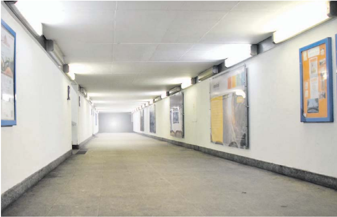
Am Ende des Tunnels gibt es nun wieder ein Licht: Die Stadt will die Bahnstufunterführung pünktlich zu den Heimat- tagen attraktiver gestalten.
