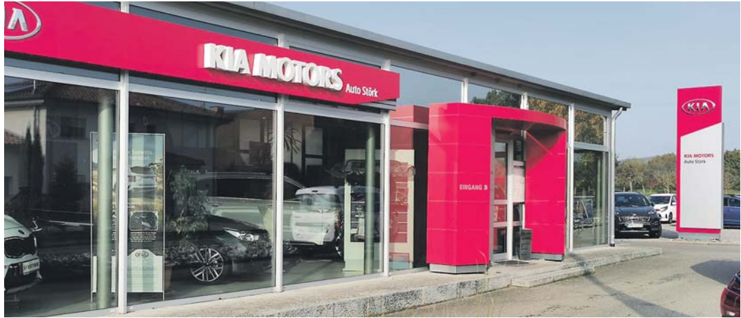
Das Autohaus Störk mit Sitz in Mühlhausen-Ehingen.
