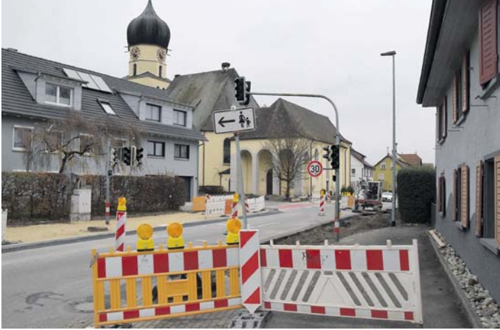
Die Bauarbeiten an der Böhringer Ortsdurchfahrt laufen auf Hochtouren.
