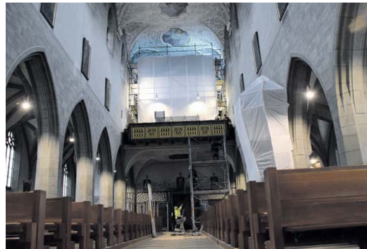
Auch Orgel und Kanzel des Münsters sind schon sicher eingepackt. Als Erstes werden nun Wände und Decken gereinigt. Dazu kommen Hubsteiger zum Einsatz. Der Innenraum muss also nicht komplett eingerüstet werden.
