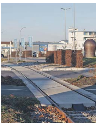
Seit September gibt es wieder das durchgehende Gleis am Volksbank-Kreisel in Singen Süd. Bis Züge fahren, wird es noch ein ganzes Weilchen gehen. swb-Bild: of
