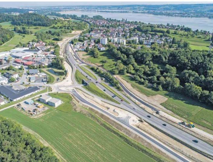
Die Situation rund um die Abfahrt Allensbach-Mitte wird sich in den nächsten Wochen stark verändern – bis im September die Anschlussstelle nebst Brücke neu erstellt ist. swb-Bild: RPF
