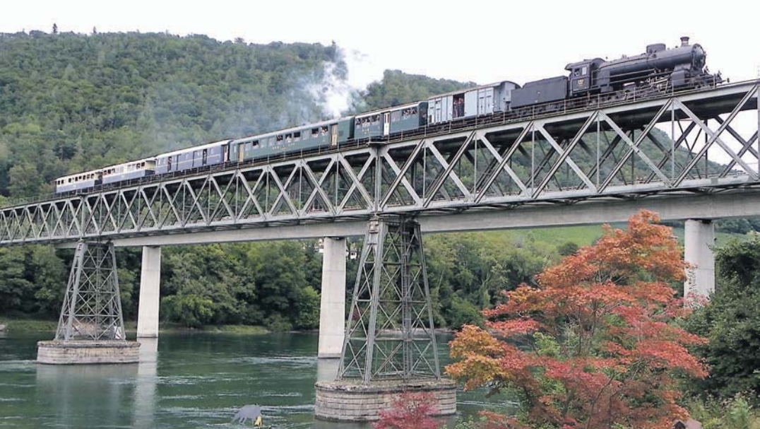
Der lange Zug auf der Hemishofer Brücke unter Dampf. swb-Bild: Wocher
