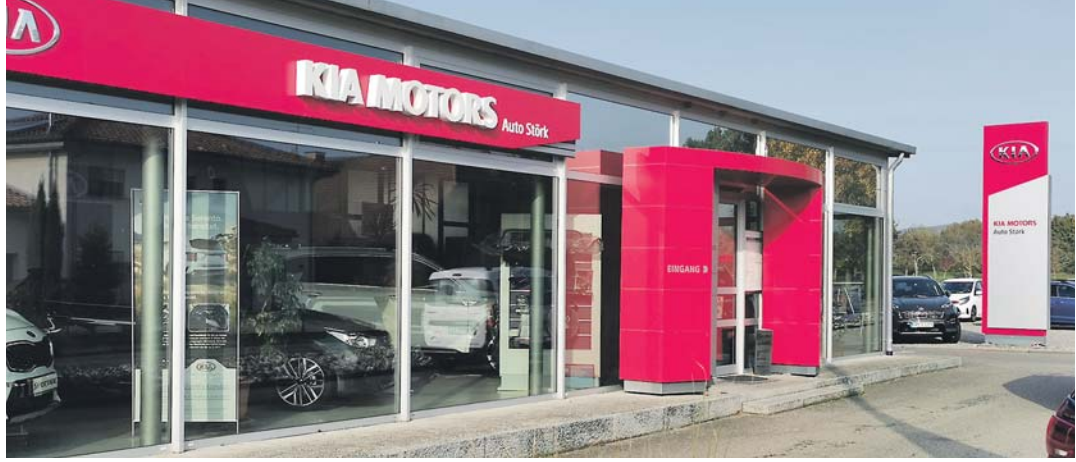
Das Autohaus Störk mit Sitz in Mühlhausen-Ehingen.
